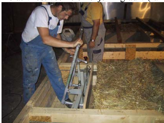
Slika 7: Vgrajevanje toplotne izolacije iz slame v lahko stensko konstrukcijo iz lesa; stenski elementi so bili izdelani v delavnici in sestavljeni na gradbišču
