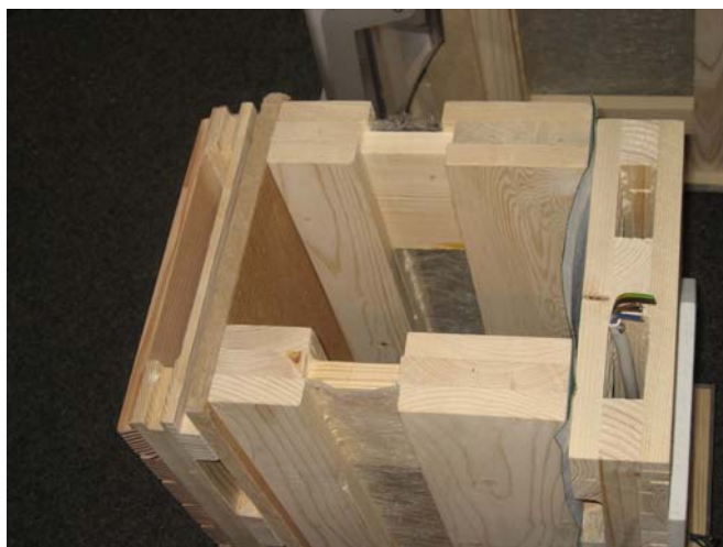
Slika 6: Modeli stenskih konstrukcij za pasivne hiše tujih proizvajalcev montažnih hiš – med lesene nosilne elemente se vstavi toplotna izolacija
