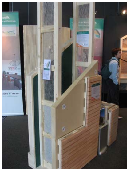
Slika 6: Modeli stenskih konstrukcij za pasivne hiše tujih proizvajalcev montažnih hiš – med lesene nosilne elemente se vstavi toplotna izolacija
