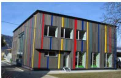
Slika: Sanacija in osnovne šole in vrta v standardu pasivna hiša, Sv. Leonhard pri Siebenbrünnu, Avstrija
