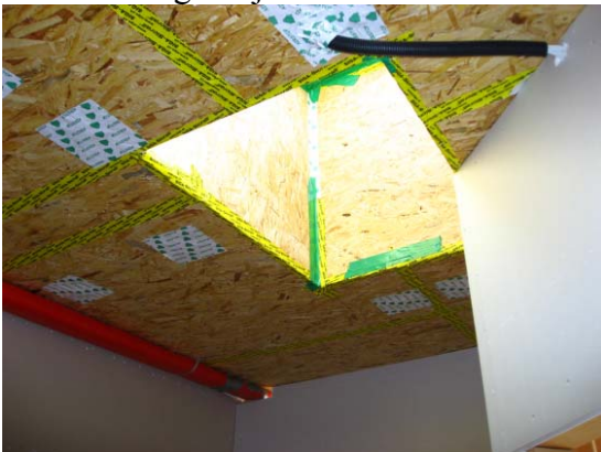
Pasivna hiša v Darmstadtu med gradnjo. Zrakotesnost zagotavljajo OSB-plošče, stiki med posameznimi elementi so skrbno zalepljeni.
