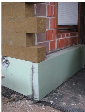
Toplotna izolacija iz kamene volne na opečni steni.
