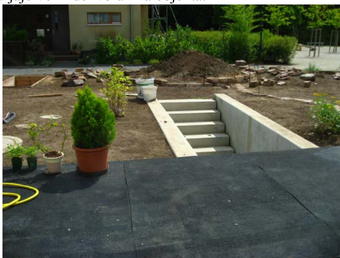
Vrstna hiša v Darmstadtu ima vhod v hladno klet, ki je pod hišo in zunaj toplotnega ovoja, od zunaj (pogled s terase med gradnjo).
