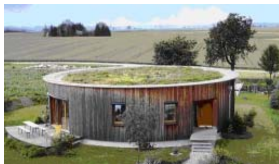
Pasivna hiša v Schwarzbachu, okrogla tlorisna zasnova zgradbe daje ugoden oblikovni faktor.
