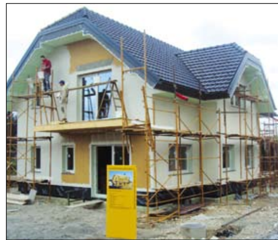
Pasivna hiša Dremelj, Ljubljana, lesena skeletna konstrukcija, Montažna gradnja Tadej Zimic s.p.
