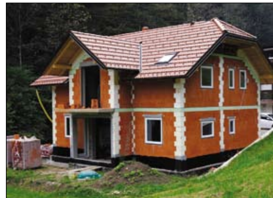
Pasivna hiša Jankovec, Belica, v gradnji, masivne stene iz opeke s toplotno izolacijo iz kamene volne, Wienerberger opekarna Ormož d.d., Knauf insulation, d.d.
