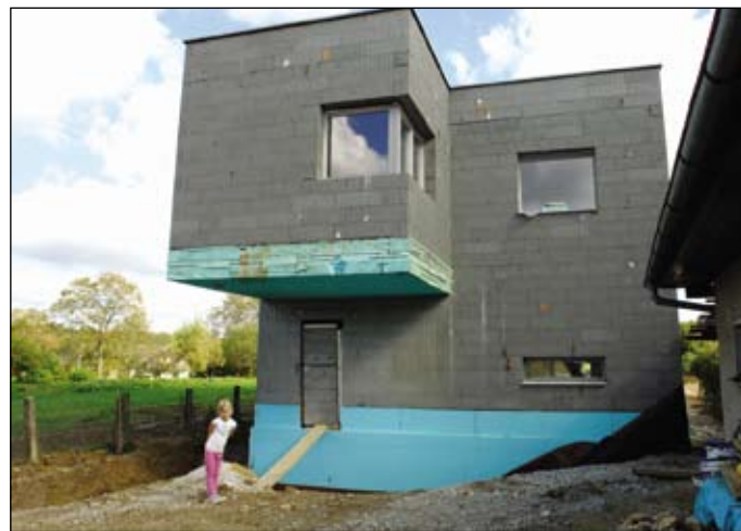
Pasivna hiša, Trinkova ulica, Ljubljana, sistem Isorast, v gradnji, Arhem d.o.o.
