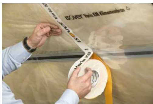
Parna ovira predstavlja zrakotesno ravnino, če je dobro zlepljena z zanesljivimi lepilnimi trakovi.
