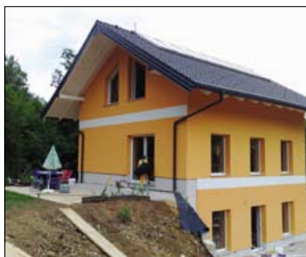
Pasivna hiša Kepec, Hočevoje, masivne stene iz porobetona s toplotno izolacijo iz kamene volne, Xella porobeton d.o.o.
