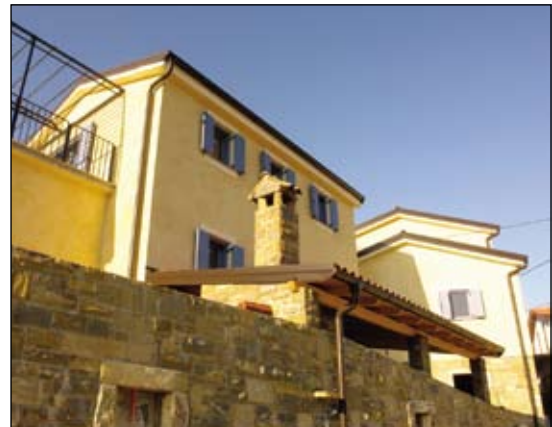
Pasivna hiša Korber Jančar, Župančiči, sistem opaznih zidakov iz neopora, Varčna gradnja d.o.o.
