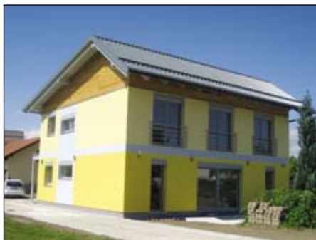
Pasivna hiša Kozin, Ljubljana, lahka montažna konstrukcija iz prefabriciranih elementov, Lumar IG d.o.o.
