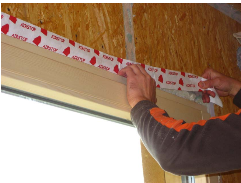
Slika 8: Zrakotesna vgradnja oken s specialnimi trakovi
