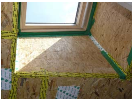
Slika 7: Zrakotesnost zagotavljajo ustrezne OSB-plošče, pomembno je skrbno stikovanje z lepilnimi trakovi. Obvezna je tudi zrakotesna vgradnja okna.
