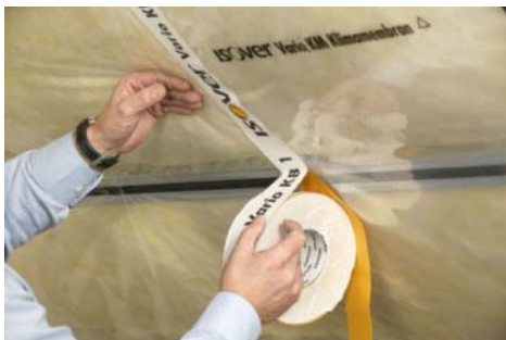
Slika 6: Parna ovira predstavlja zrakotesno ravnino, če je dobro zlepljena z zanesljivimi lepilnimi trakovi.
