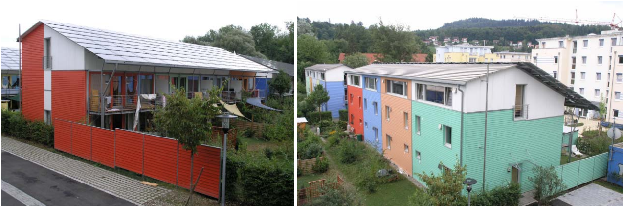
Plusenergijsko stanovanjsko naselje Schlierberg v Freiburg, levo - pogled na južno fasado, desno - pogled na severno fasado
