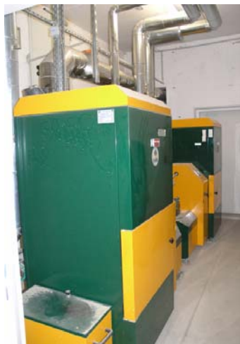
Osnovno šolo v Frankfurtu ogrevata dve 60 kW peči na pelete.
